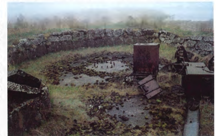
Mökerikkössä oli Talvisodan loppuun asti 6" Canet-patteri. Jatkosodan aikana linnakkeen kalusto oli 75-millinen. Kevyet tykit oli sijoitettu entisiin isoihin tykkiasemiin. Uudet isännät ovat käyttäneet Mökerikköä koelatausalueena. Merimiinojen ankkurikoneistoja on hajan hajan saarella, myös molempien tykkiasemien pohjilla (Ove Enqvist).
