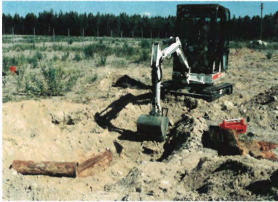
Pioneerien kaivinkone työssään Hanko Pohjoisessa.
