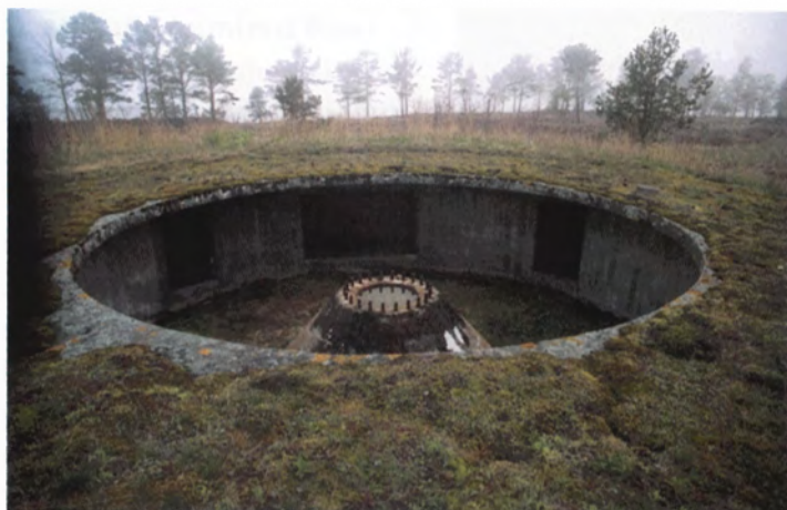
Ristisaari on pieni, kallioinen ja vaikeasti rantaanpäästävää saari Valamon ja Mantsinsaaren puolivälissä. Saarella oli ennen Talvisotaa 6" Canet-patteri. Jatkosodan aikana samoissa asemissa oli 120 mm:n Vickersit. Tykkiasemat kasematteineen ovat erittäin hyvin säilyneitä (Ove Enqvist)
