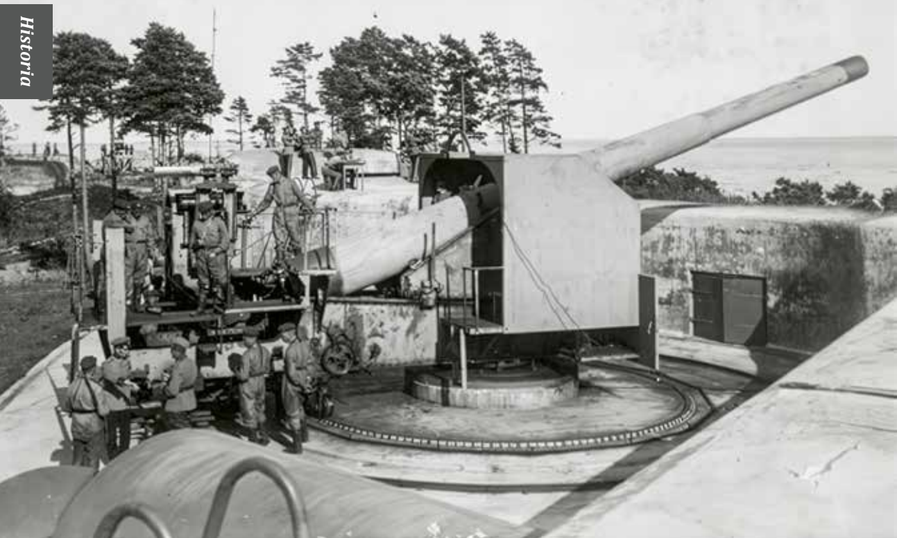
Rysäkarin 254 mm:n 45 kaliiperin merikanuuna mallia Durlacher. Tykin takana näkyy betoninen komentotorni ja vasemmalla takana valonheitinasema.
